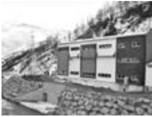
Vizara HES Santral Binası
