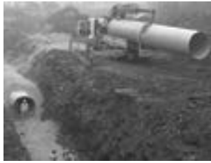
Akdere HES Cebri Boru, CTP - 4000 m
