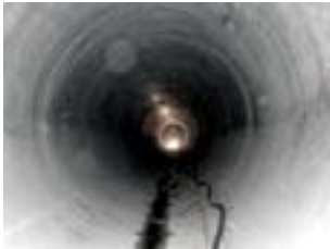
Yedigöl HES Basınçlı Tünel L = 6400 m, H = 290 m
