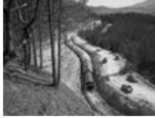
Paşa HES İletim Hattı Betonarme Kondüvi
