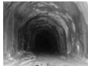
Kayaköprü 1 HES Kaplamasız Tünel - 8000 m
